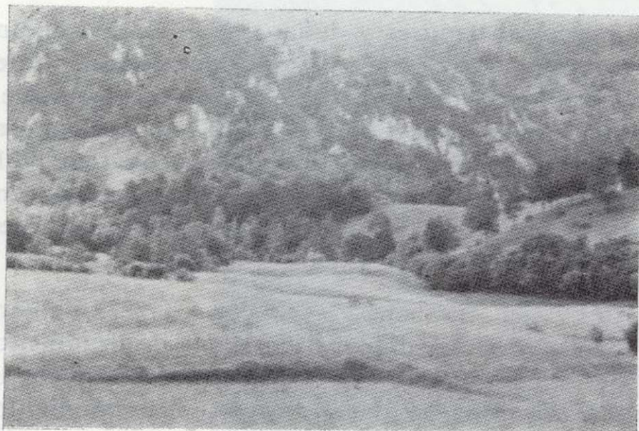
Figura 3.—Vista del deslizamiento de Inza. Al fondo, acantilado de calizas arrecifales cretácicas con desprendimientos.
